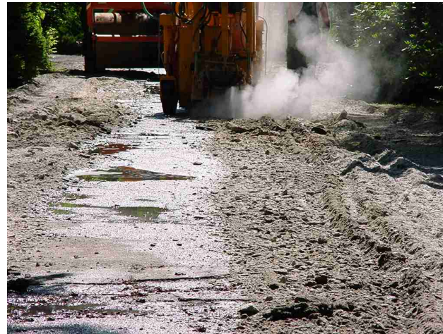
Beton - oder Asphaltzerkleinerung
