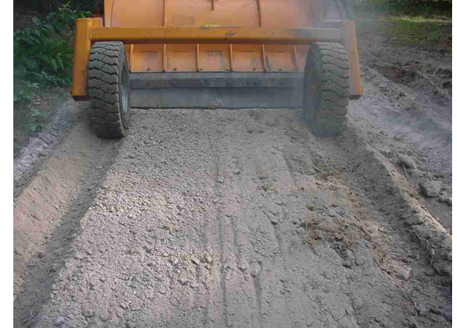
Der Brecher bricht alte Tragschicht und mischt Brechkornmischung bis 20 cm Tiefe mit ein
