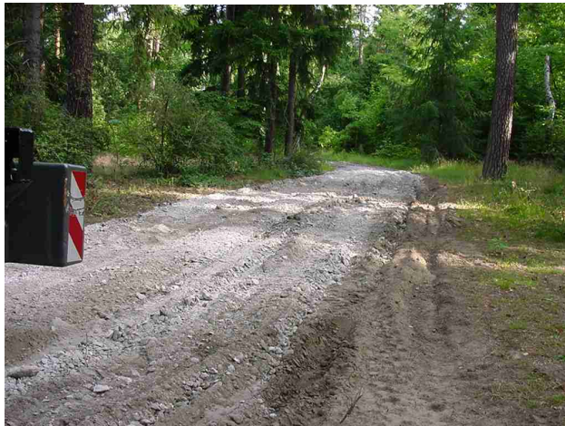
Weg mit aufgebrachtem Mineralgemisch
