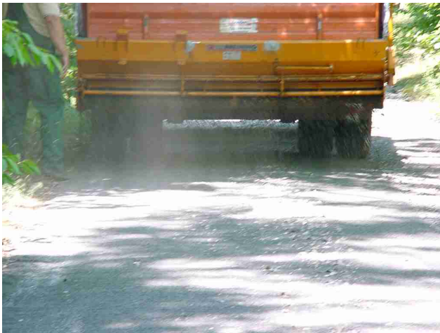
Aufbringen der Deckschicht mit Splittleger aus geringer Fallhöhe
