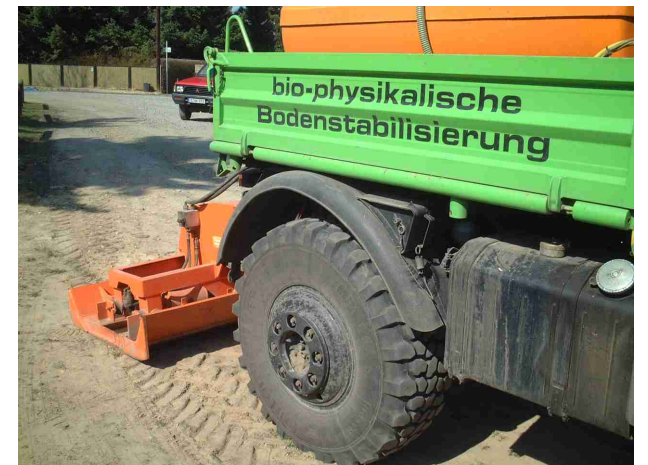
Plattenverdichter glättet und verdichtet
